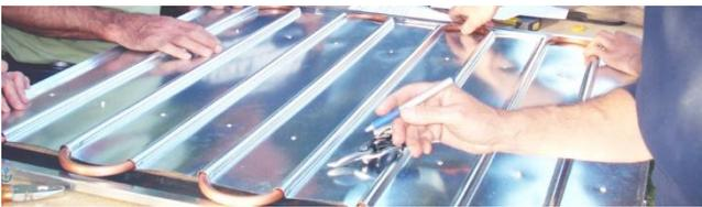
**OBJECTIFS :** Comprendre le fonctionnement puis fabriquer un capteur solaire thermique.
