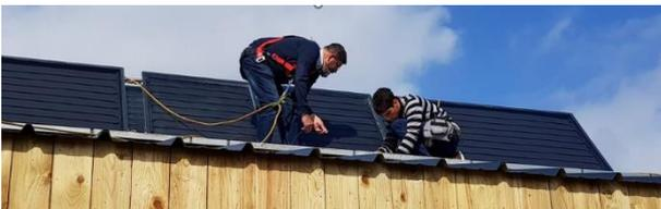
**OBJECTIFS :** Mettre en place et fixer des capteurs solaires thermiques en toiture inclinée ou au sol et les raccorder hydrauliquement avec le ballon de stockage. Mettre en service et régler une installation solaire thermique.
